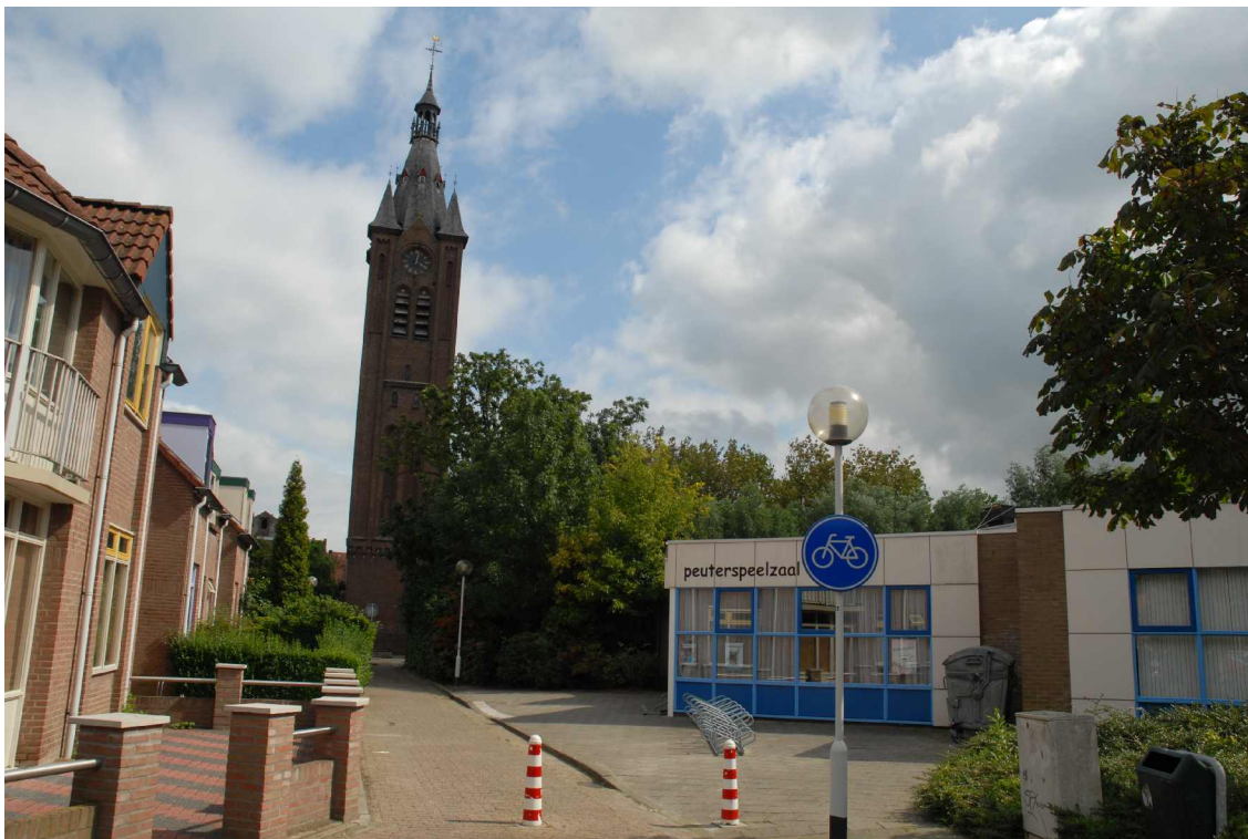
Foto 6. Willibrordustoren, een bolwerk voor de Gierzwaluw.
