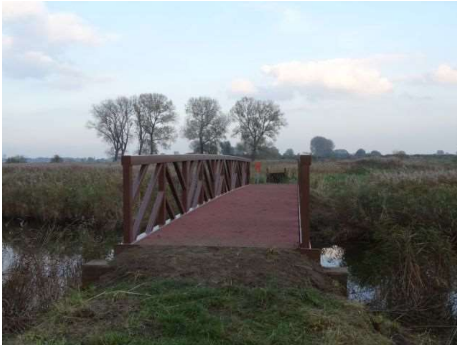
De nieuwe stalen brug
